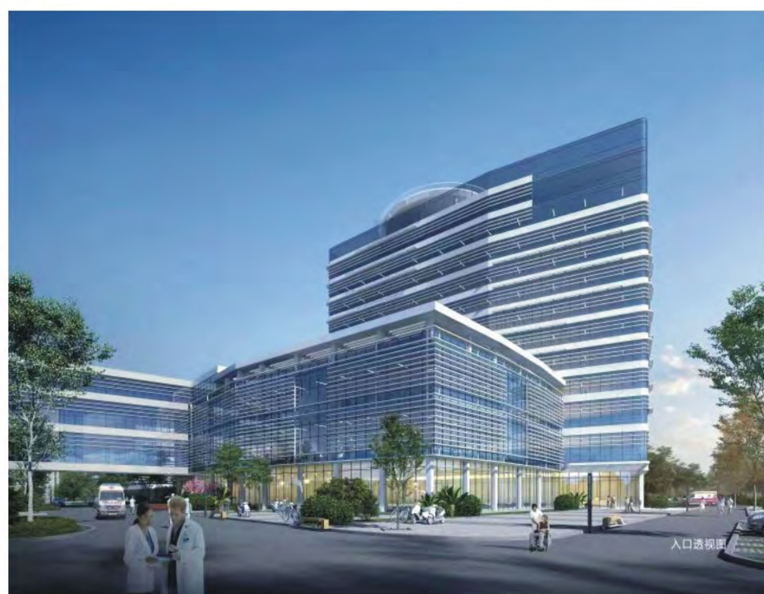
■ 温岭市公共卫生临床中心项目
