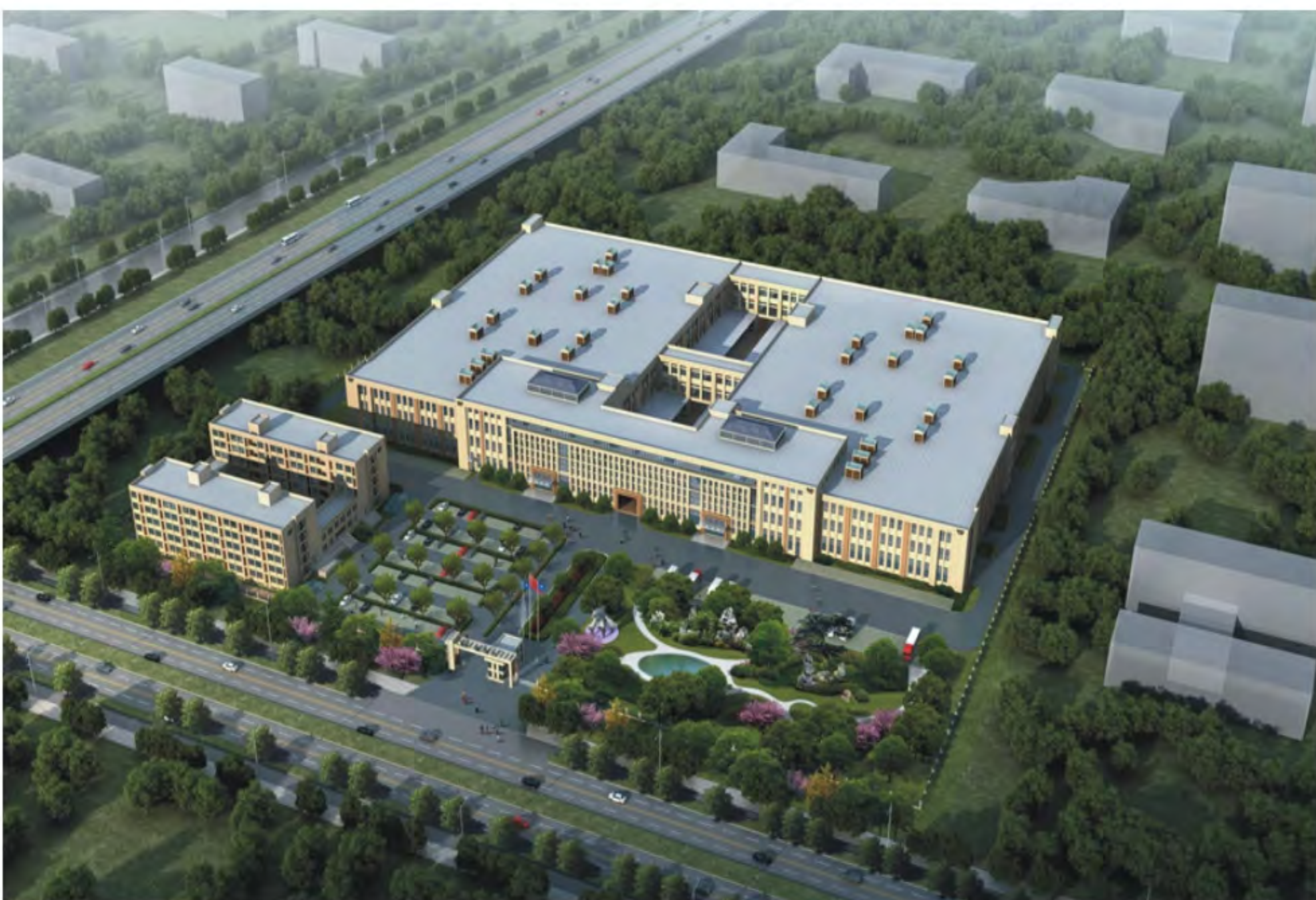
新天力纸塑容器有限公司厂房建设项目
