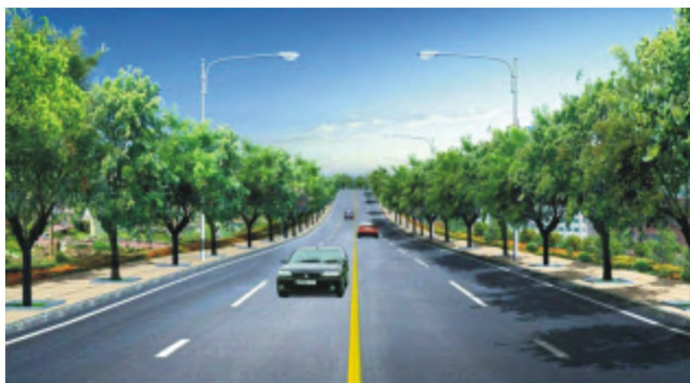
2015年度浙江省建筑安全文明施工标准化工地 温岭市泽国镇东河南路道路工程I标段
