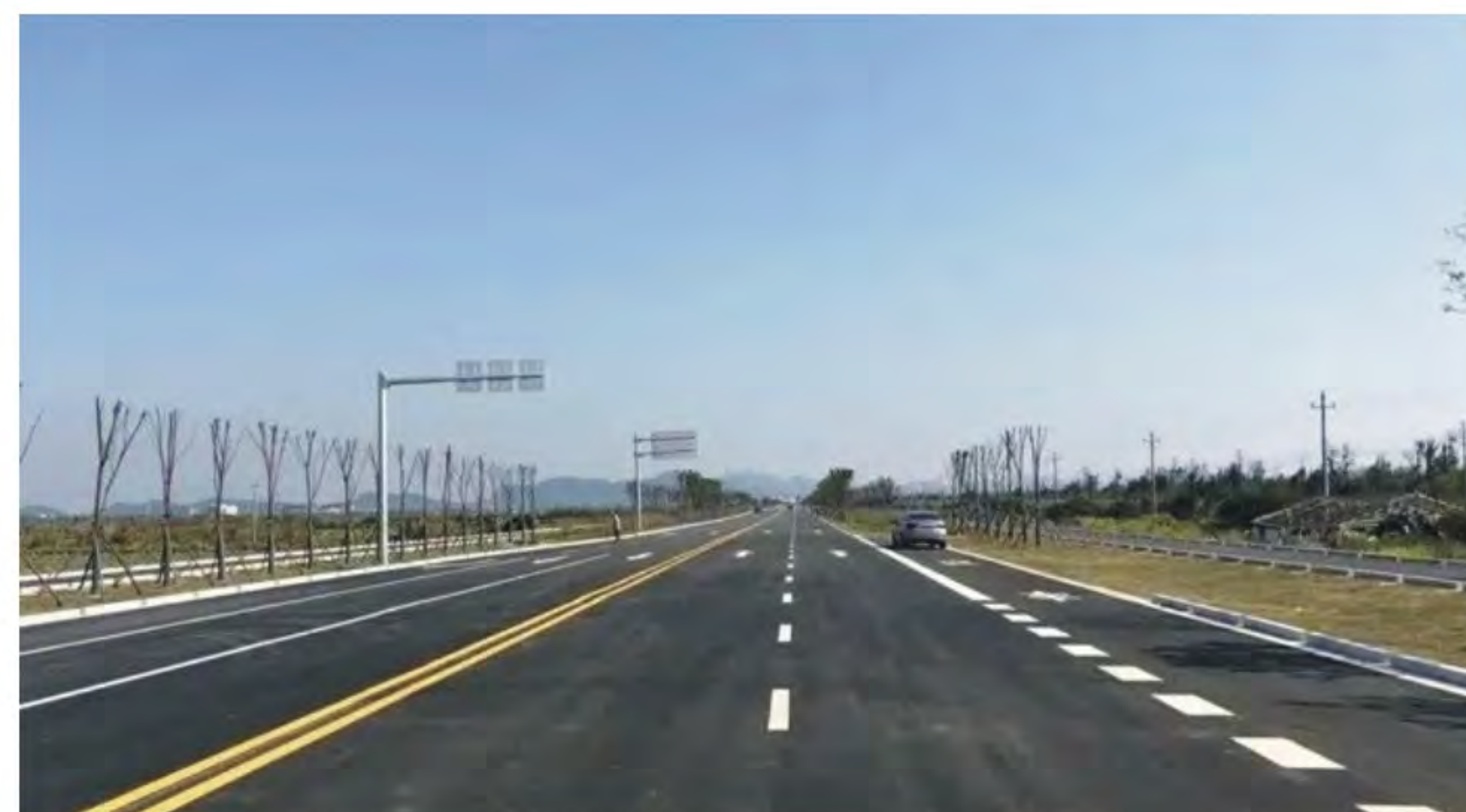
2020年度浙江省建筑施工安全生产标准化管理优良工地 温岭市东部新区金塘中路市政道路工程
