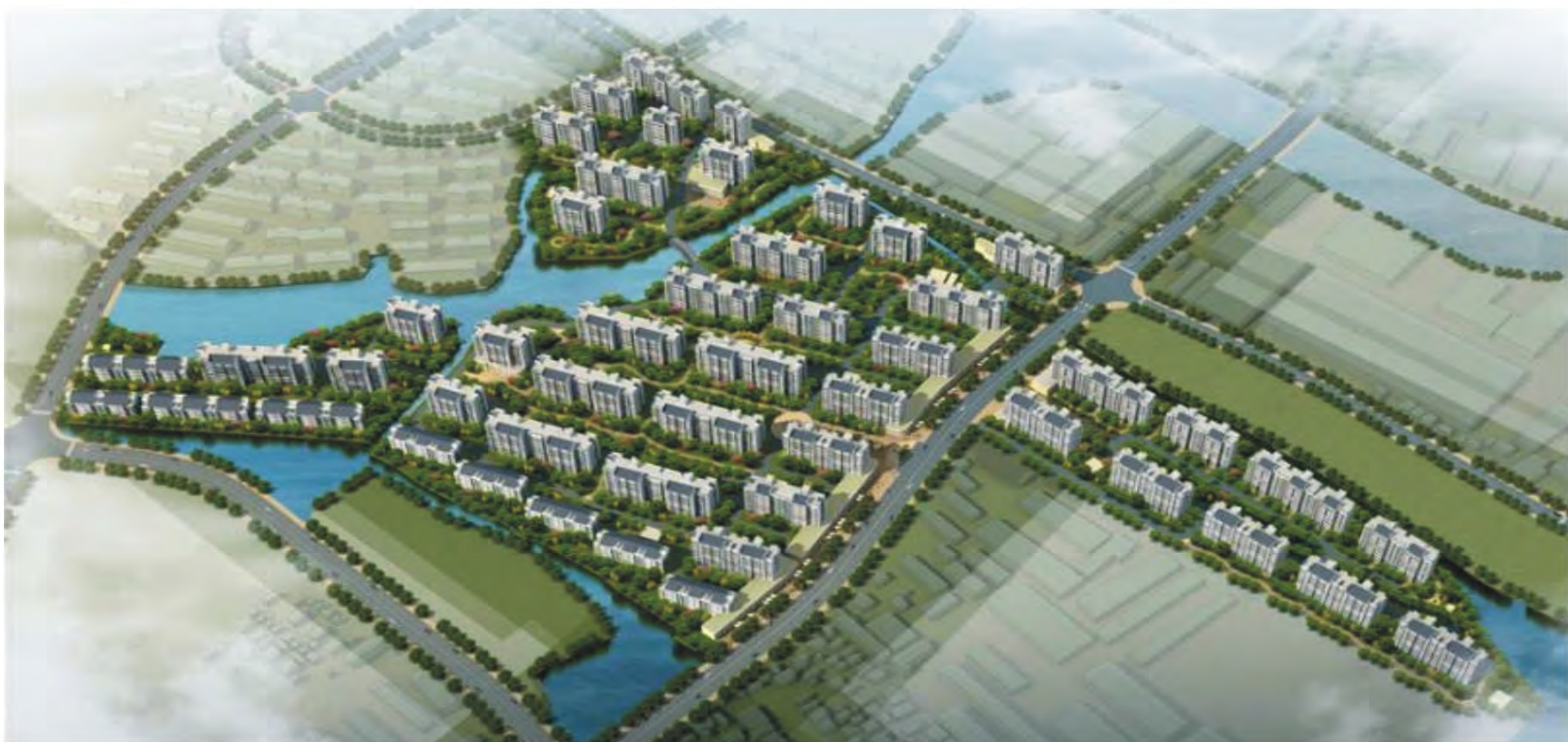
绍兴市柯桥区堰东、堰西、丁巷拆迁安置小区项目
