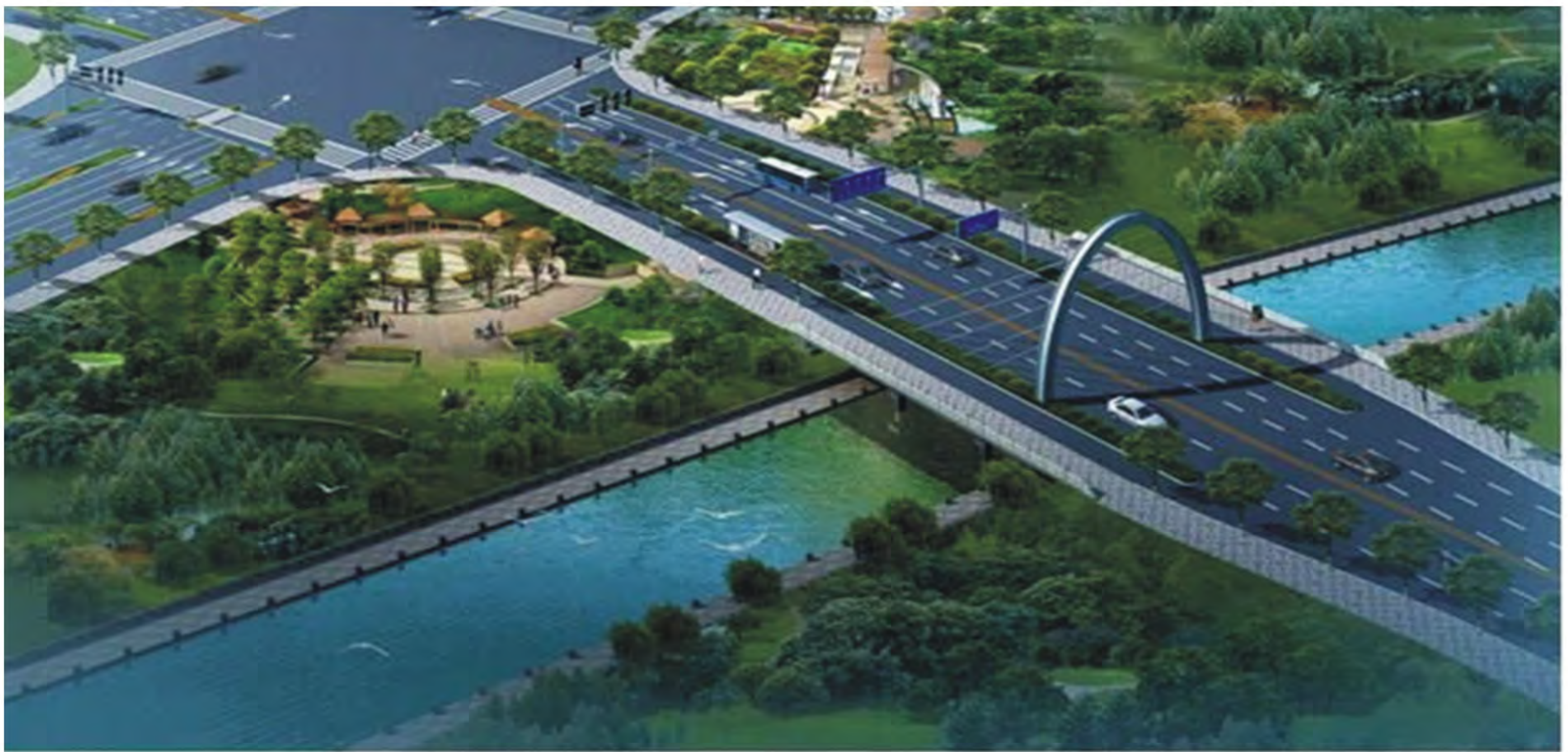
■ 温州市瓯海区城市中心区环屿路、东一路工程
