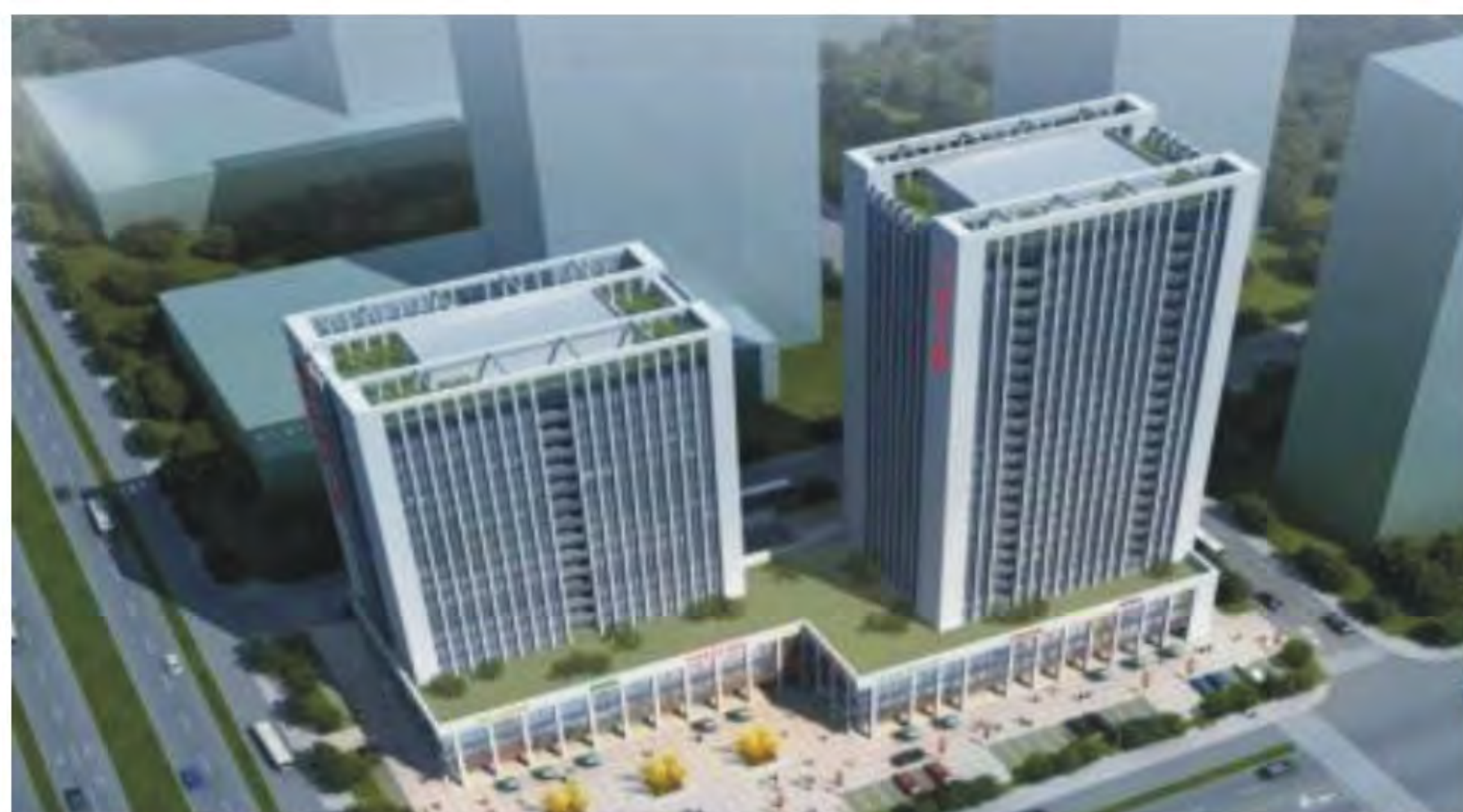
2019年度浙江省建筑施工安全生产标准化管理优良工地 临海市建筑业大楼
