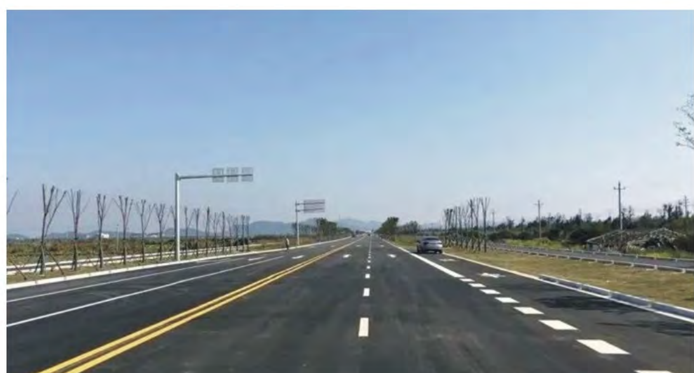
2021年度浙江省建设工程钱江杯奖 温岭市东部新区金塘中路市政道路工程
