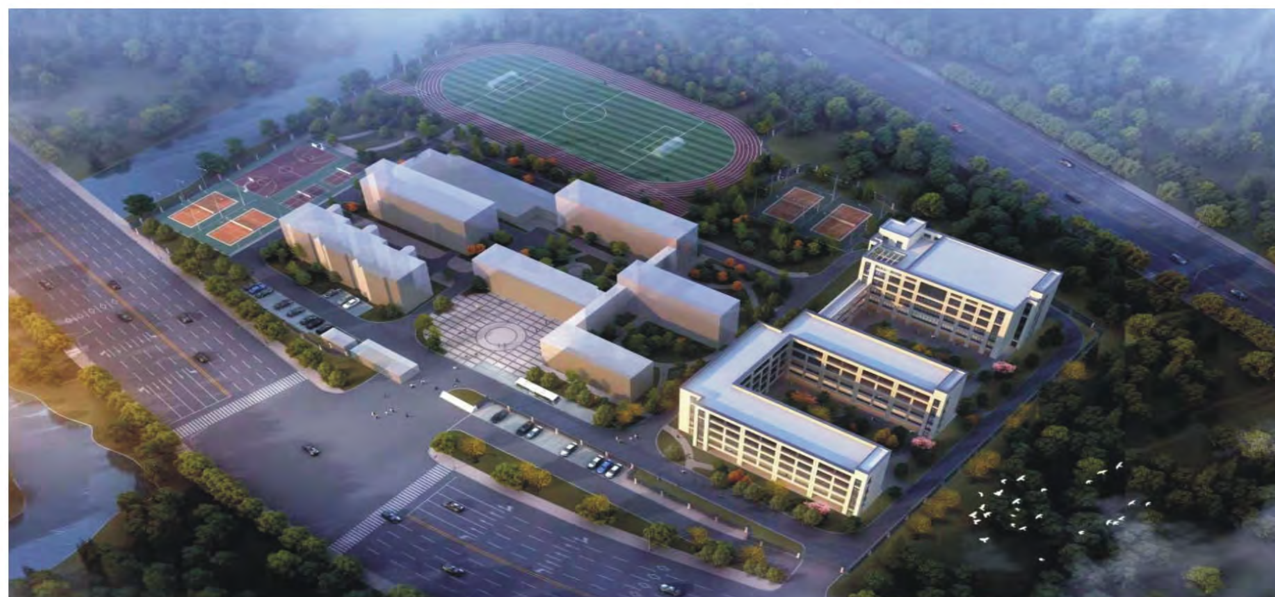
温岭市松门镇淋川中学扩建工程
