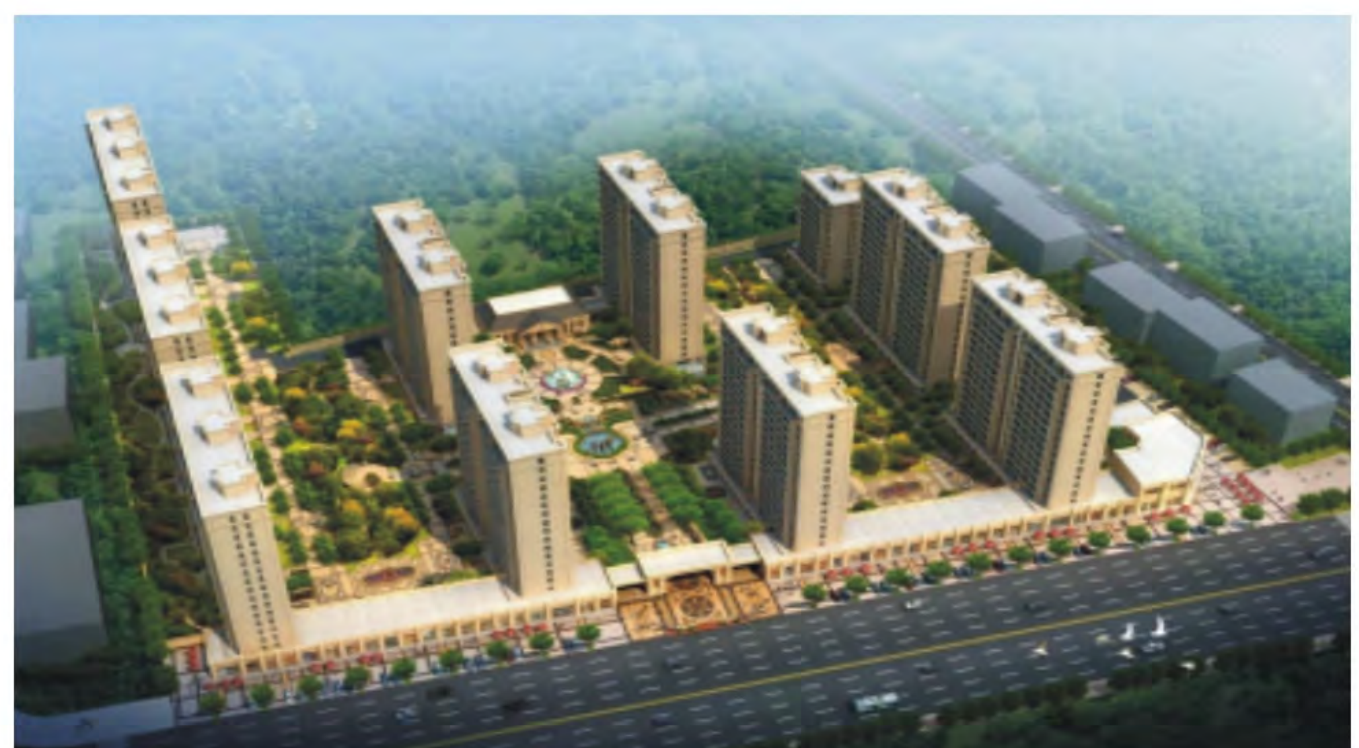
2017年度浙江省建筑安全文明施工标准化工地 香溪望府工程
