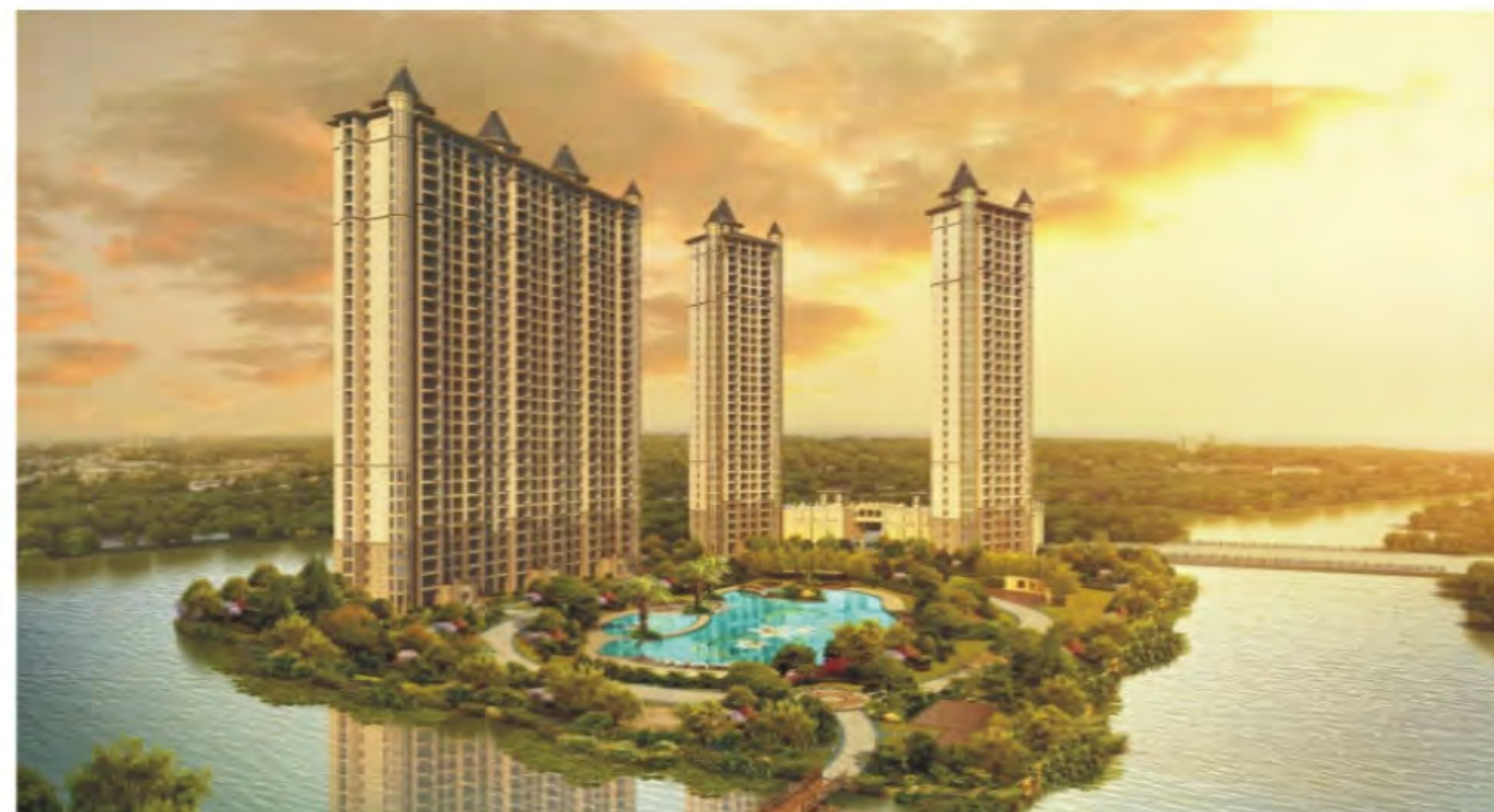
2020年度浙江省建筑施工安全生产标准化管理优良工地 温岭市城西街道湖畔壹号三期
