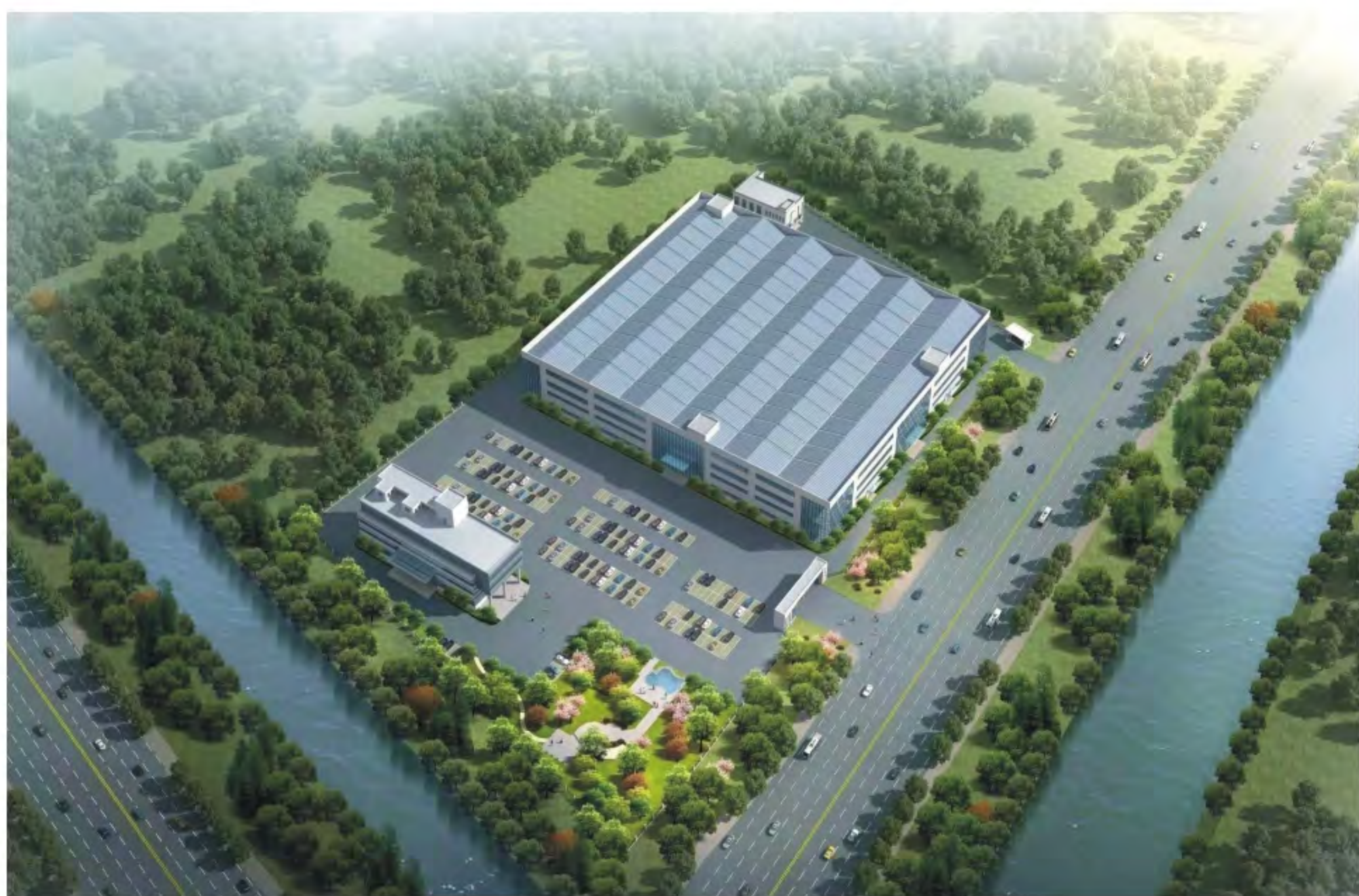
浙江乐骑机车有限公司新厂区建设项目
