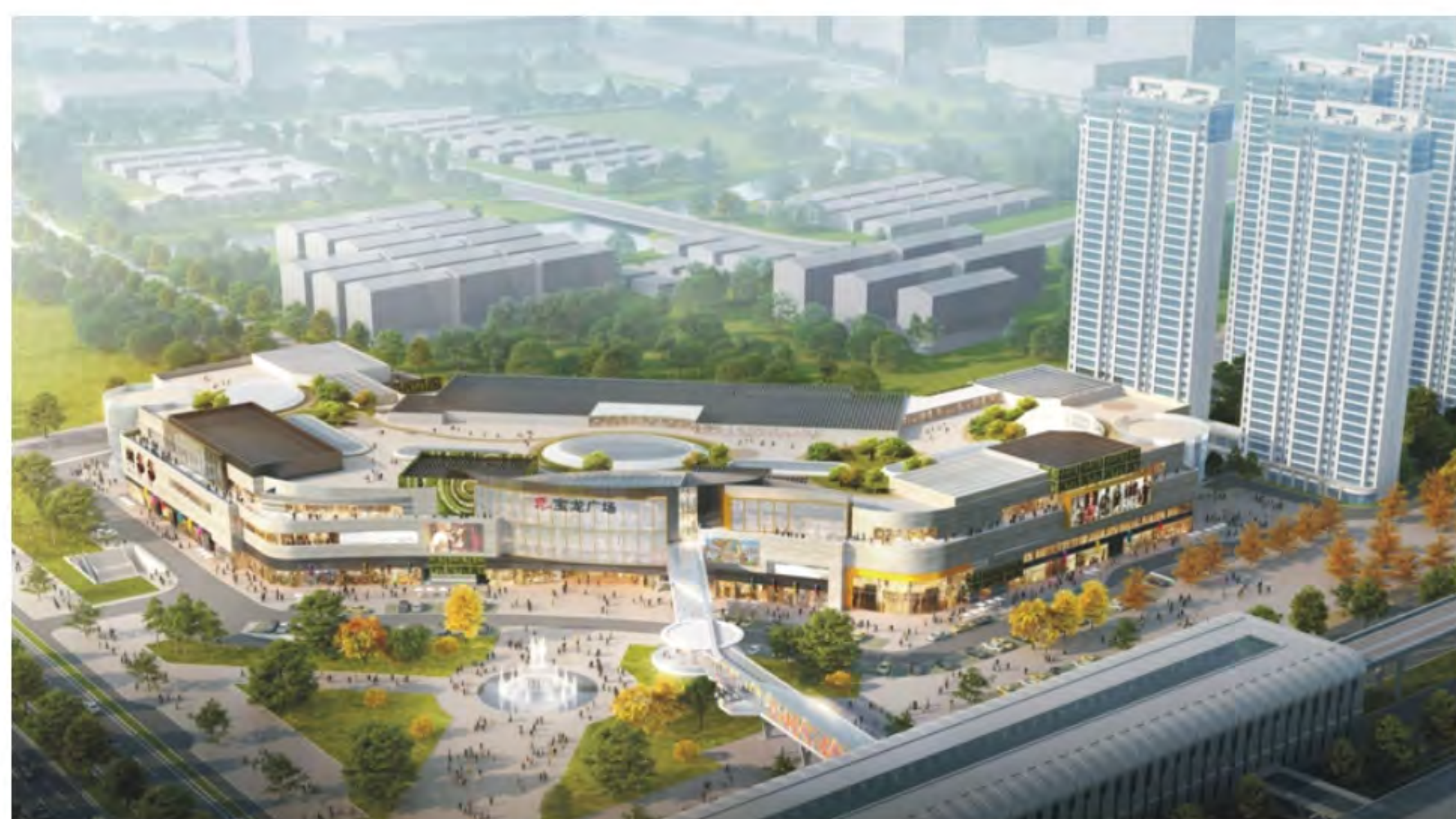
2021年度浙江省建筑施工安全生产标准化管理优良工地 宝龙生活广场一期工程
