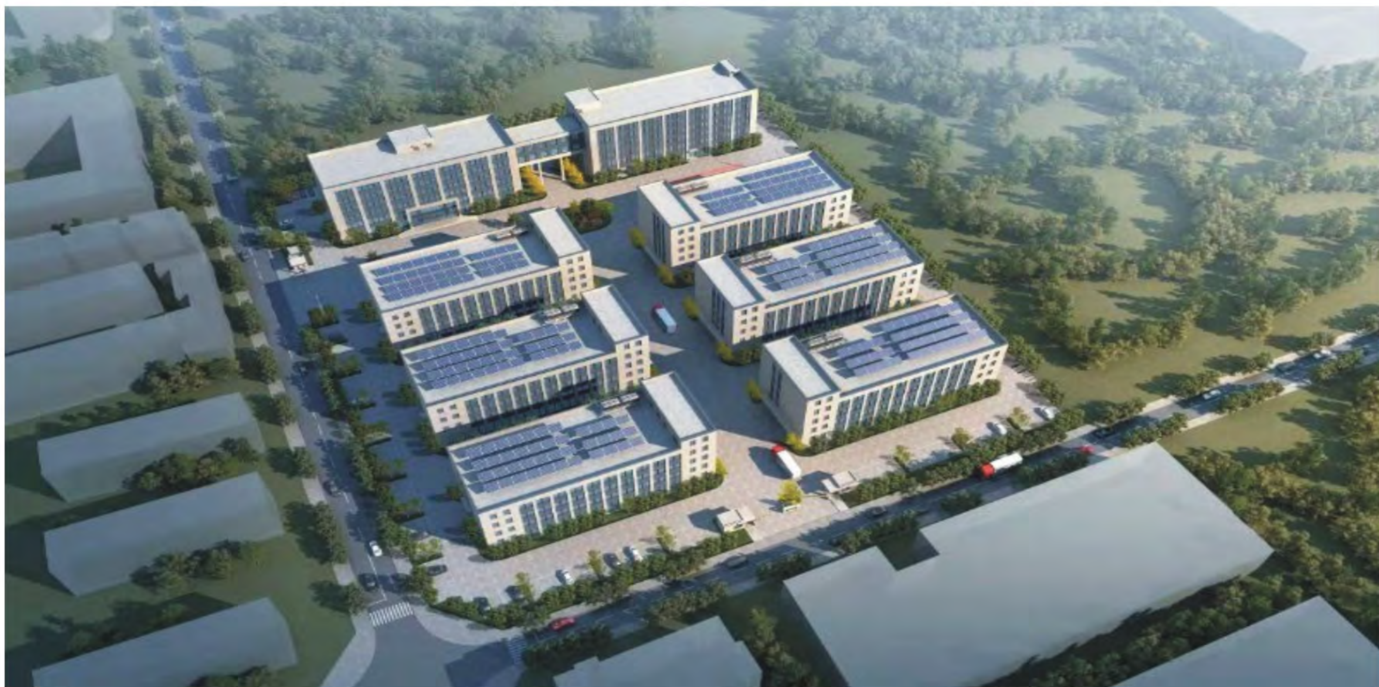
智能电气智慧制造产业厂房建设项目
