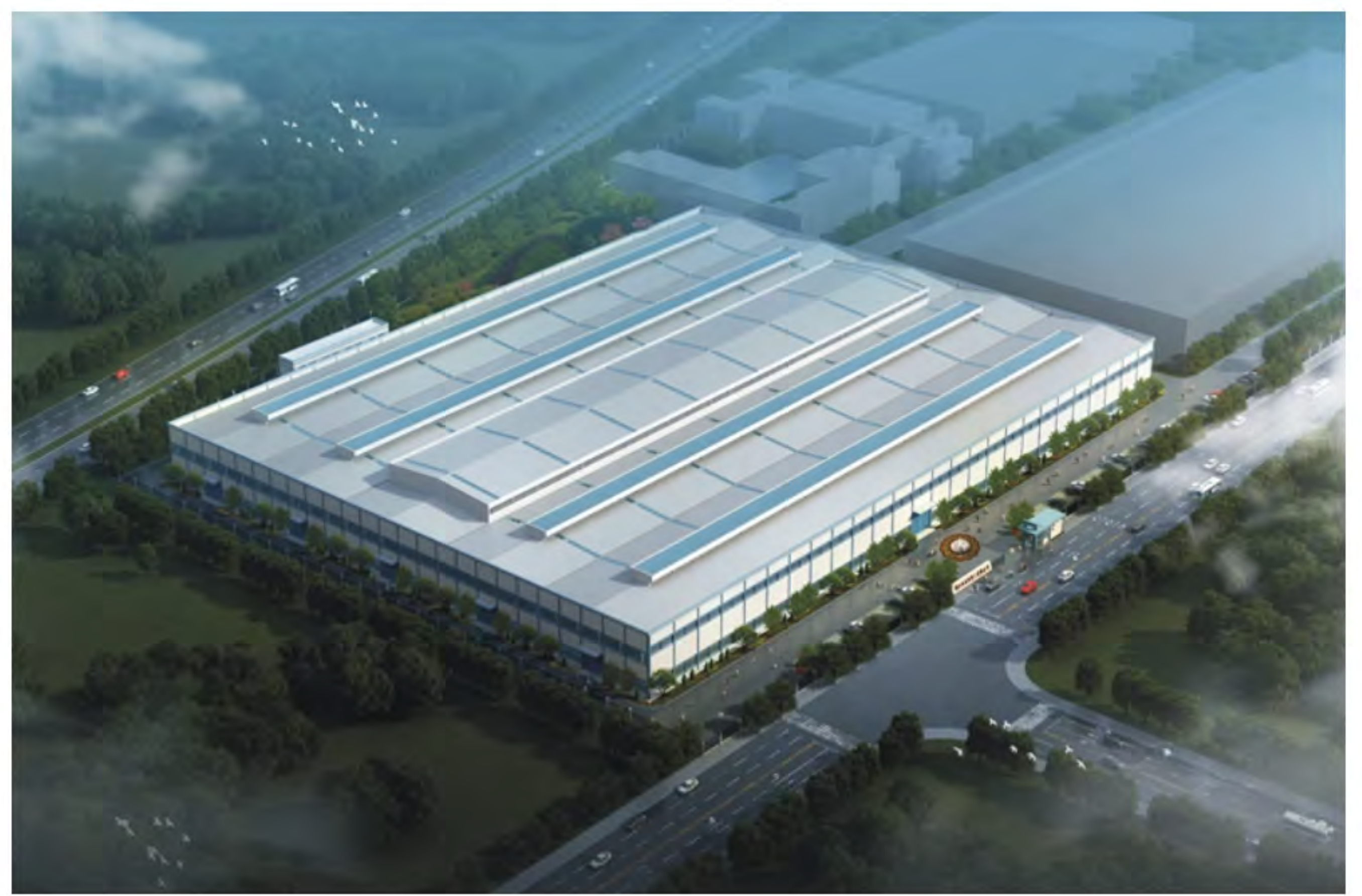
浙江红五环机械股份有限公司厂房建设项目
